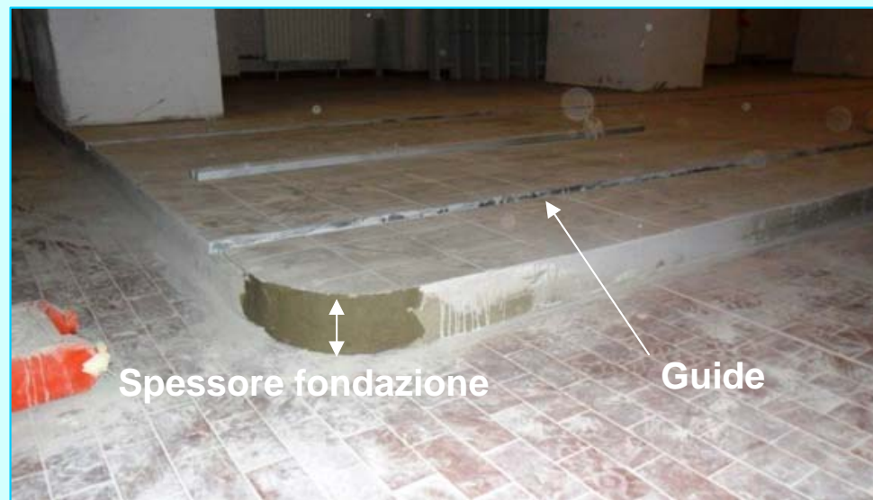
Annegamento delle guide di scorrimento nell'opera di fondazione degli archivi compattabili
