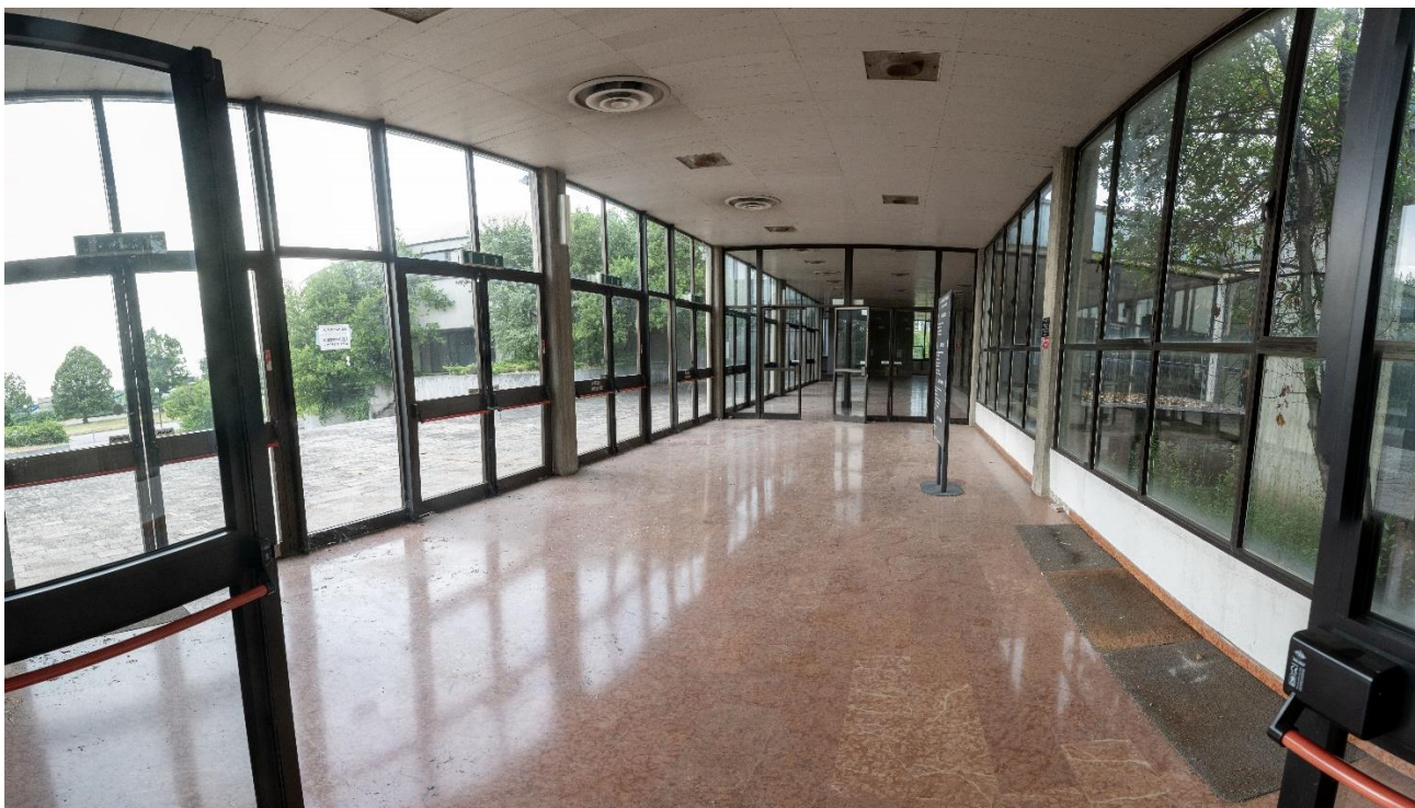
DETTAGLIO DEL SOFFITTO
