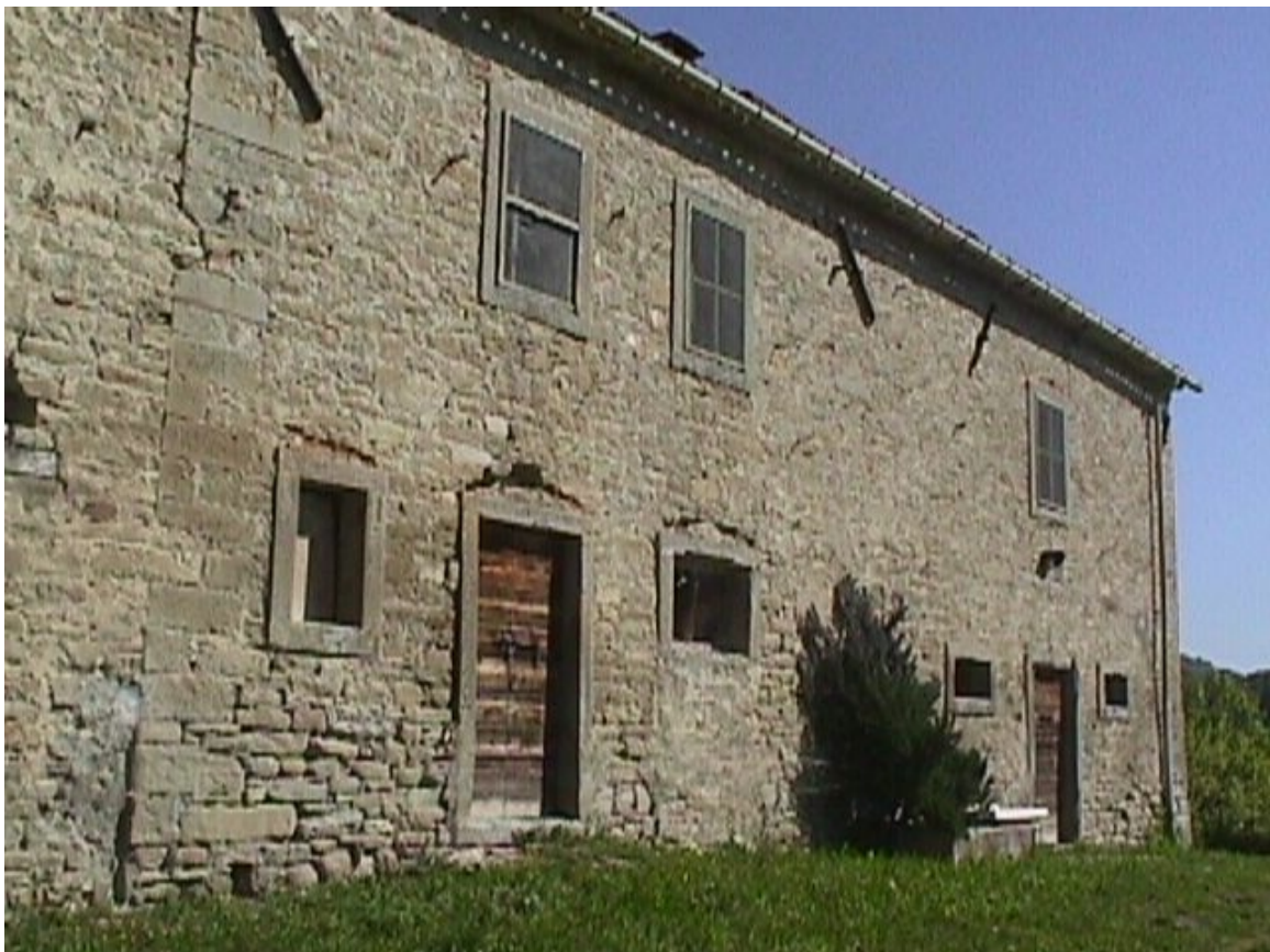
Denominazione Bene VALLICELLA Comune SANTA SOFIA Didascalia PARTICOLARE PROSPETTO SUD
