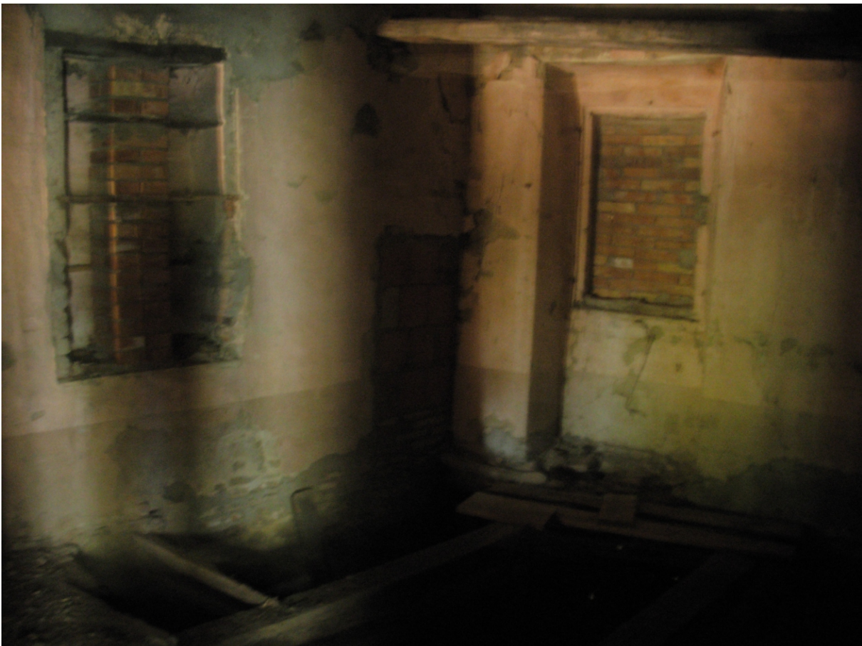
Denominazione Bene MONTALTO Comune SARSINA Didascalia INTERNO CAMERA PIANO TERRA
