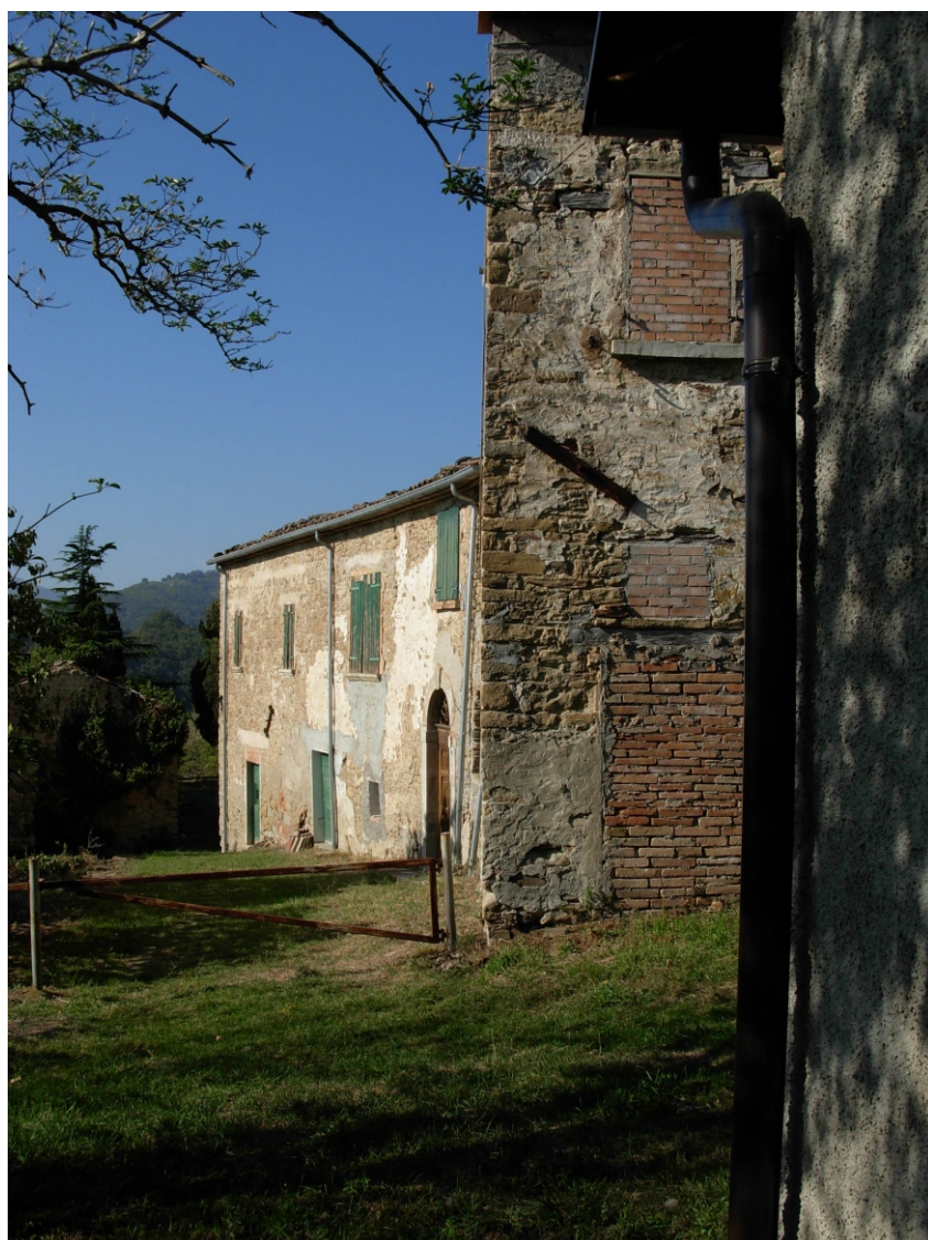
Denominazione Bene MONTALTO Comune SARSINA Didascalia ACCESSO CANTINA PIANO SEMINTERRATO
