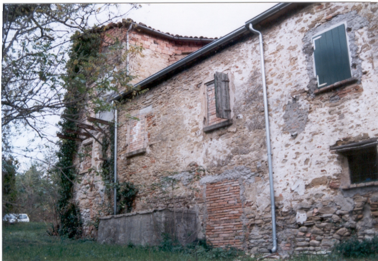
Denominazione Bene MONTALTO Comune SARSINA Didascalia PROSPETTO NORD
